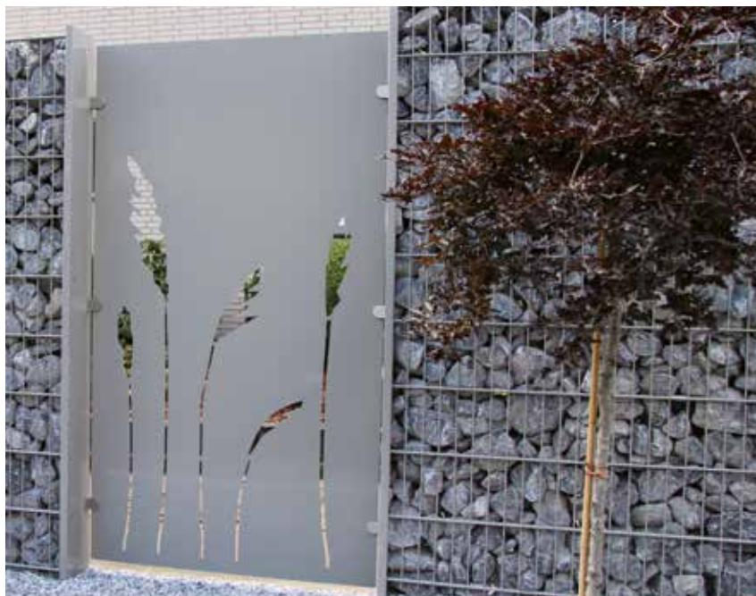
Gabionen in Kombination mit Designblech-Elementen Modell Schilf, steingrau pulverbeschichtet
