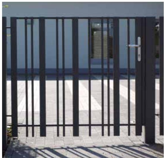
Tor mit aufgesetzter Stabfüllung
