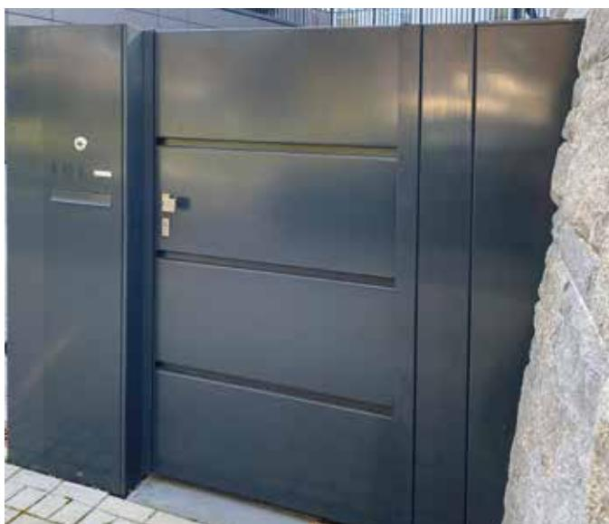
Tor mit Kassettenblechfüllung und waagerechter Sicke
