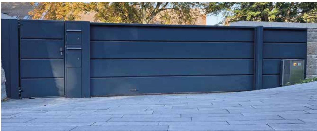
Schiebetor mit Kassettenblechfüllung und waagerechter beidseitiger Sicke
