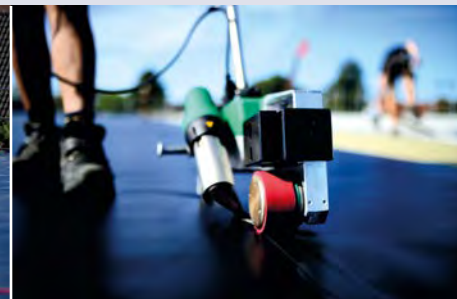
Präzisionsarbeit: Längsnahverschweißung mit dem Schweißautomaten
