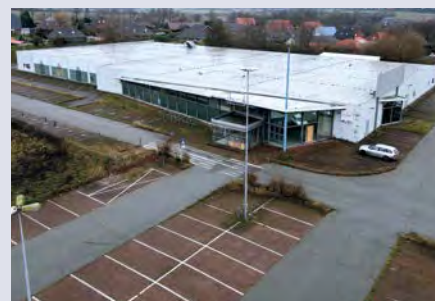
Einkaufszentrum vor der Sanierung
