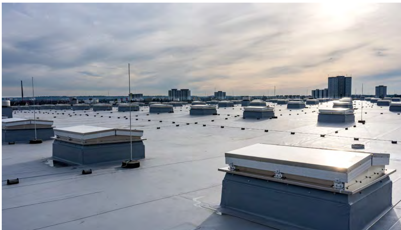
Bei den vorhandenen RWA und Lüftern wurde die Dachbahn am oberen Abschluss mit einem Verbundblech befestigt, die Abdichtung an der Aufkantung hochgeführt und mit dem Verbundblech thermisch verschweißt
