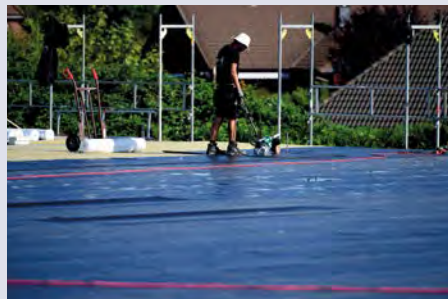
Präzisionsarbeit: Längsnahverschweißung mit dem Schweißautomaten
