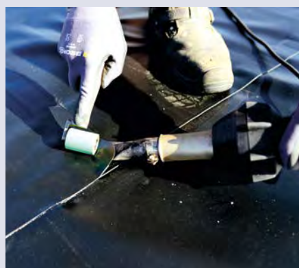
Handarbeit: Am Stoß und bei Details wie den Dachdurchdringungen der Lüfter arbeiteten die Dachdecker mit dem Heißluftfön
