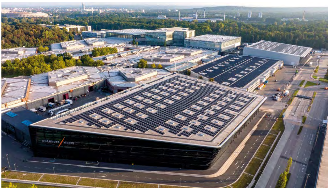
Die Hallendächer der NürnbergMesse werden mit neuen Dachbahnen und PV-Anlagen versehen
