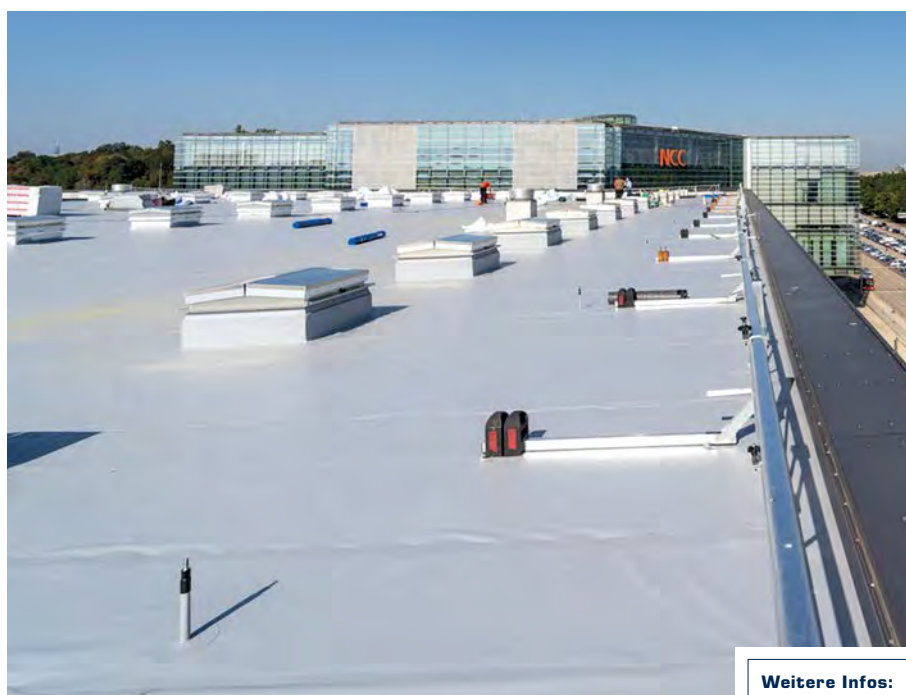
Auf dem 7.500 qm großen Dach der Halle 4A befinden sich insgesamt 98 Rauch- und Wärmeabzugsanlagen (RWA) und acht Lüfter
