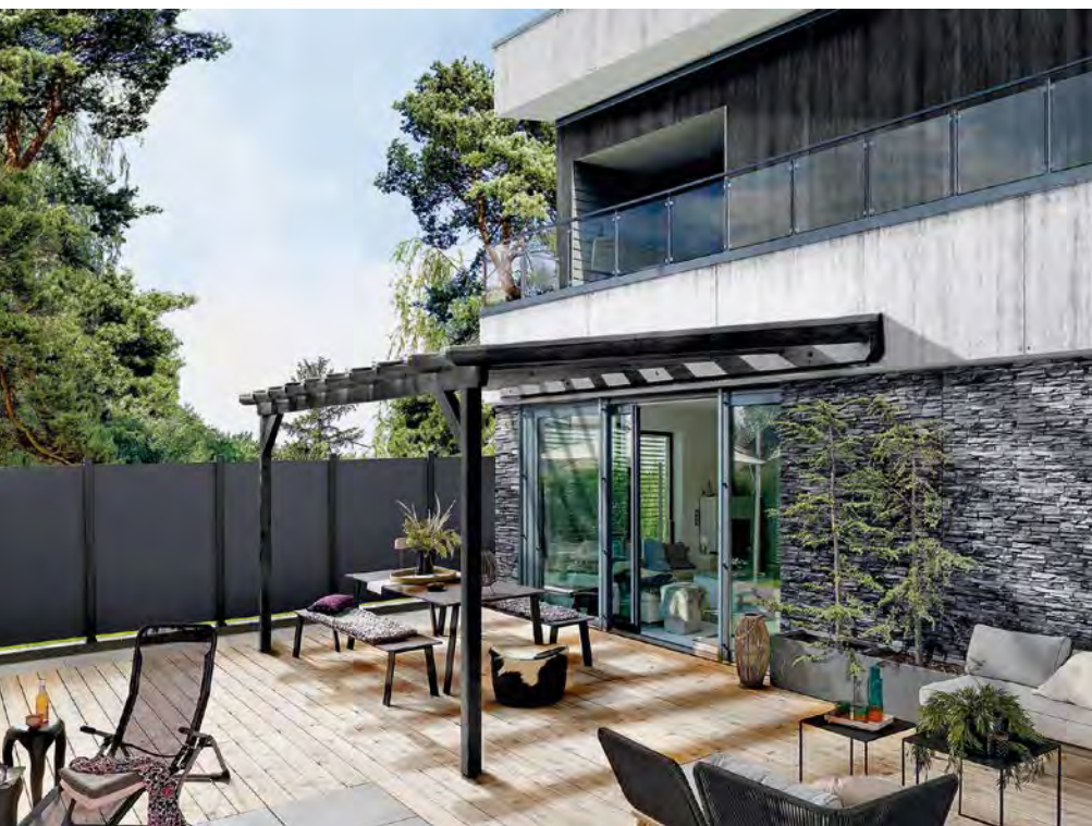
Die Fassade mit neuem Gesicht – mit Alucom Design-Exterieur an der Wand in drei attraktiven Dekoren. Passend dazu auch der Sichtschutz mit Platten in KRONOART® Anthrazit.
