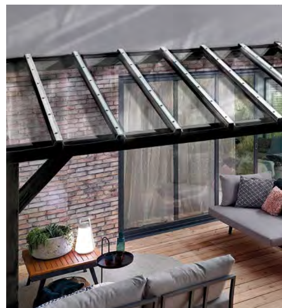
Die stabile Überdachung schützt die Terrasse und den Eingang zum Wohnbereich. Die PC-Stegplatten Marlon Premium Longlife in Glasklar lassen Tageslicht durch und bieten garantierten Schutz vor Witterungseinflüssen. An der Fassade wurden unifarbene, graue Aluverbundplatten mit einem Ziegeldekor kombiniert.
