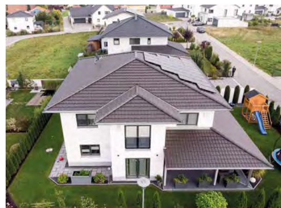
Dachsanierung, Aufstockung oder Anbau mit der Reformpfanne SL in Anthrazit Foto: ERLUS, Golsner Bau, Jan Kobel
