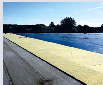
Drei Stufen der Sanierung: links die Kunststoffbahn des Altdachs, in der Mitte die zusätzliche Mineralwolle-Dämmung, rechts die neue Abdichtung mit Wolfin M
