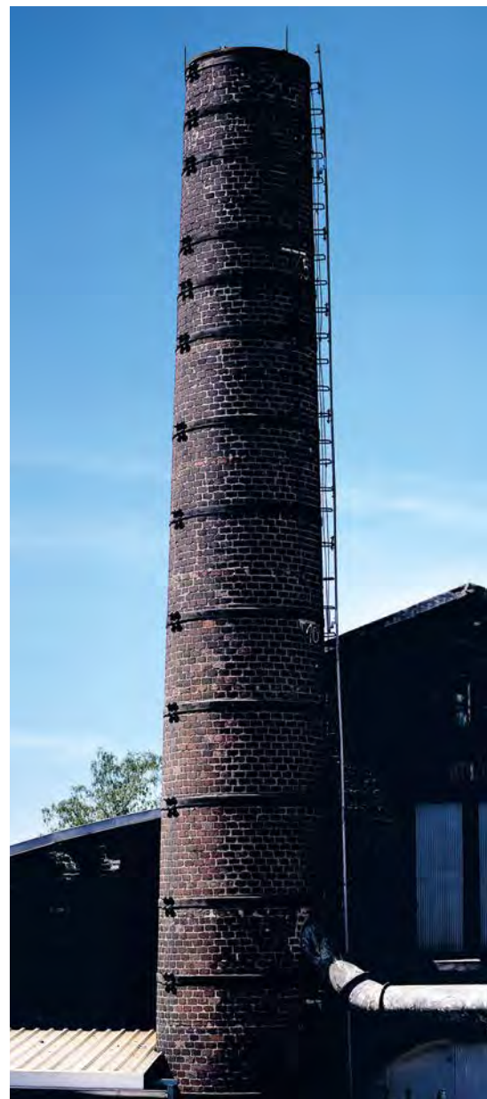
Der historische Schornstein der Schmiede
