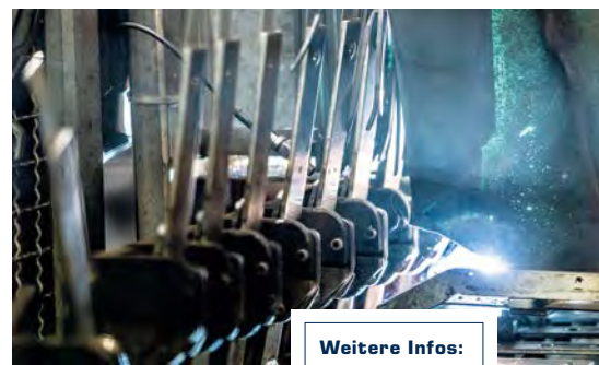
Schneefangitterstützen werden geschweißt
