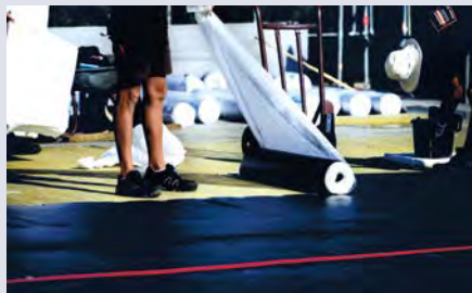
Dichtheit von der Rolle: Verlegung der Sanierungsbahn Wolfen M auf der Wärmedämmung
