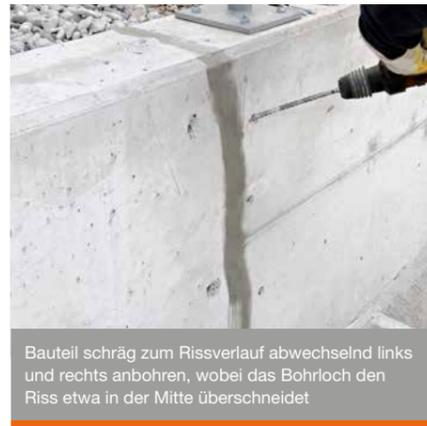
Bauteil schräg zum Rissverlauf abwechselnd links und rechts anbohren, wobei das Bohrloch den Riss etwa in der Mitte überschneidet
