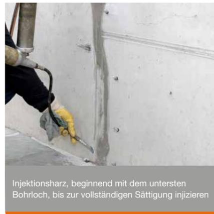
Injektionsharz, beginnend mit dem untersten Bohrloch, bis zur vollständigen Sättigung injizieren
