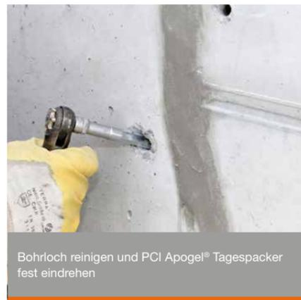
Bohrloch reinigen und PCI Apogel® Tagespacker fest eindrehen
