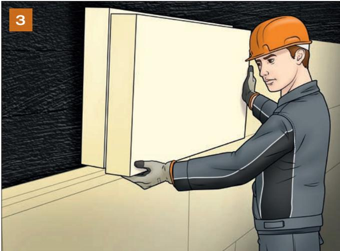
Die Hartschaumplatten in entsprechender Dicke gemäß der aktuell gültigen EnEV waagrecht von unten nach oben mit versetzten Stößen an der Außenwand anbringen. Der Stufenfalz ist mit Gefälle nach außen anzuordnen.
