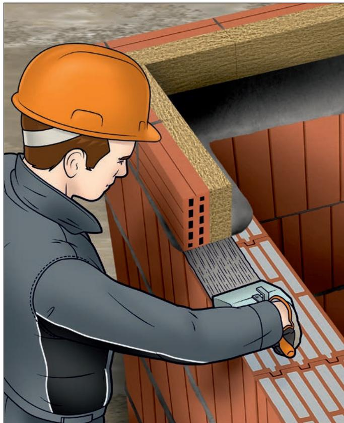
Versetzen von Deckenrandsteinen in Dünnbettmörtel. Deckenrandsteine, die aus demselben Material bestehen wie die Außenwand, reduzieren die Wärmebrücke im Deckenauflegerbereich, die durch das Aufeinandertreffen von Mauerwerk und aufliegender Betondecke entsteht.
