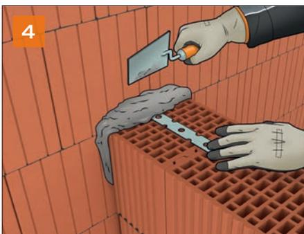
4 Bei Aufmauern der Querwände Anker aufbiegen und waagrecht in die Lagerfugen einbetten.
