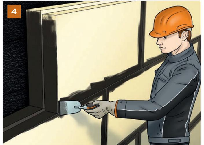
Im drückenden Grundwasser die Plattenfugen und -stöße verspachteln. Dadurch wird ein Hinterströmen und Aufschwimmen der Hartschaumplatten verhindert und die Dämmwirkung der Dämmschicht bleibt dauerhaft erhalten.
