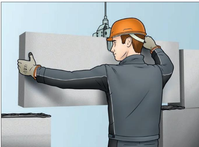
Versetzen eines Fertigteilsturzes in Mörtelbett
