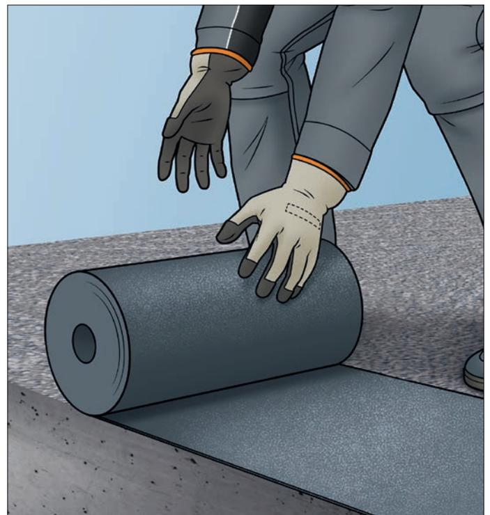
*Verlegung Mauersperrbahn in Wandbreite im späteren Wandverlauf gegen aufsteigende Feuchtigkeit.*
