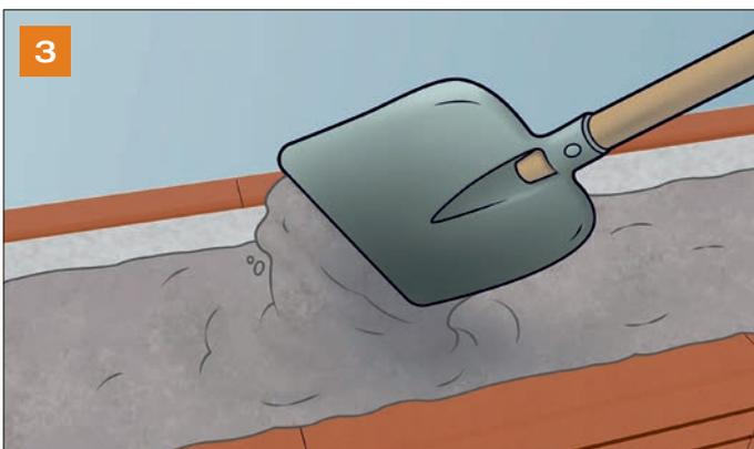
Gegebenenfalls Sparrenaufleger für Dachstuhl montieren und U-Schale ausbetonieren.
