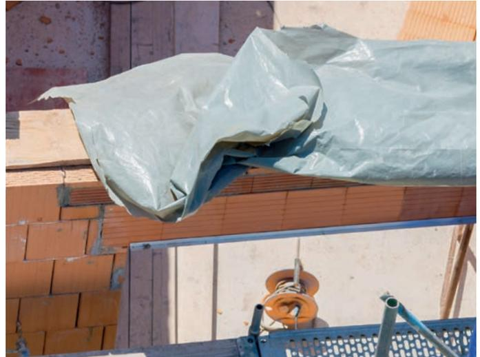
Voraussetzung für das Mauern sind Luft- und Bauteiltemperaturen von mindestens +5 °C. Darunter drohen Frostschäden. Diese Mindesttemperaturen sollten auch innerhalb der ersten Woche nach Fertigstellung nicht unterschritten werden. Ein Einsatz von Frostschutzmitteln ist nicht zulässig. Sollten Teile des Mauerwerks von Frost betroffen sein, müssen diese wieder entfernt werden.
