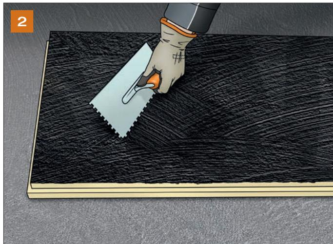
**Vollflächiges Dünnbettverfahren:** Beim Dünnbettverfahren zuerst eine Kontaktschicht auf die Platte spachteln und anschließend mit einem Zahnspachtel den Bitumenkleber vollflächig auf die Platte auftragen. Bei der Verklebung der Platten untereinander sowie im erdberührten Bereich ist eine vollflächige Verklebung im Dünnbettverfahren erforderlich.
