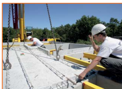
11.15 Uhr Jetzt erfolgt das Auflegen der Kellerdecke.
