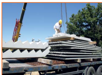
8.00 Uhr: Anlieferung der Keller-Bauteile.
