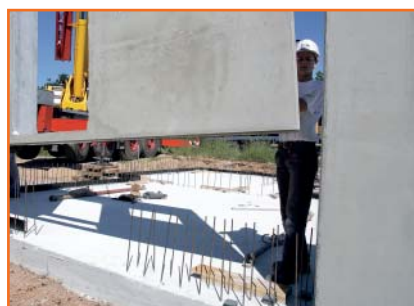
8.30 Uhr: Die Wandelemente für den Keller werden nach dem Montageplan auf die Bodenplatte gestellt.
