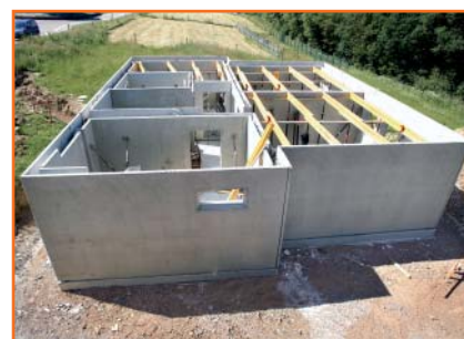
11.00 Uhr: Die Montage der Wände ist abgeschlossen.
