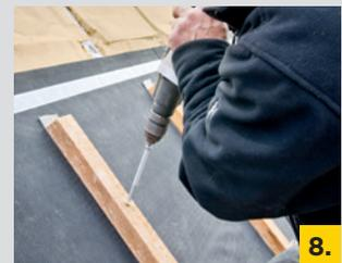
**5.** Beide Abdeckstreifen synchron abziehen und mit der Hand glatt anstreichen. **6.** Die Dachfläche ist im abgedeckten Bereich sofort nach Verklebung aller Überlappungen regensicher. **7.** Nageldichtband Vario® AntiSpike im Sparrenverlauf auf die Unterdeckbahn kleben. **8.** Mittig auf den Nageldichtbändern Konterlatten mittels Integra AB twin-UD Spezialbefestiger aufschrauben. Auf keinen Fall Nägel oder Standardschrauben verwenden!
