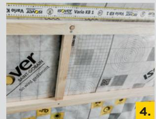
1. ULTIMATE Klemmfilz-035 lässt sich hochkomprimiert verpackt leicht transportieren. 2. Klemmfilz ausrollen, lichten Sparrenabstand plus 10 mm Klemmzugabe abmessen und abschneiden. 3. Zugeschnittenen Dämmfilz zwischen die Sparren klemmen. Auf fugendichten Anschluss achten. 4. Vario® Klimamembran fachgerecht einbauen und Unterkonstruktion zur Lagefixierung (z. B. Lattung) anbringen.
