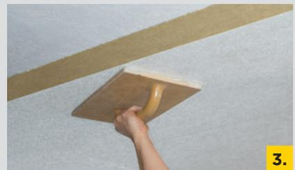
**Klebmontage:** 1. Kleber mit gezahntem Kammspachtel (10 mm) vollflächig mit leichtem Druck auf die Rückseite der Deckenplatte auftragen. Die seitlichen Kanten bleiben kleberfrei. 2. Die Deckenplatte fugendicht ansetzen. 3. Mithilfe eines sauberen Reibebretts andrücken.
