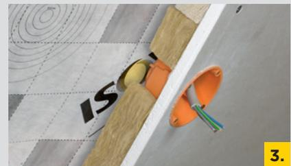
**1.** Zur parallelen Fixierung der Lattung einfach eine zugeschnittene Holzlatte als Abstandshalter verwenden. Die Lattenabstände orientieren sich an den Vorgaben der InnenbekleidungsHersteller, maximal jedoch 500 mm Rastermaß. **2.** Montagestreifen UniFix mittig antackern (vier Befestigungen pro m<sup>2</sup>), dann Dämmstoff einlegen. **3.** So können auch tiefe Installationsebenen für Gerätedosen oder Einbaustrahler komfortabel gedämmt werden.
