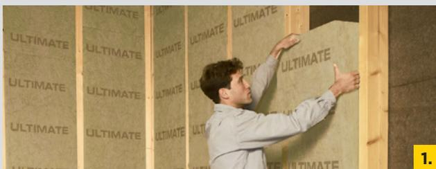
**1.** ULTIMATE Holzbauplatte-035 einfach in das Gefach einstellen und festdrücken, sodass keine Hohlräume zwischen Dämmung und Beplankung verbleiben. Wichtig: die Plattenkanten dicht anschließen, damit keine Wärmebrücken entstehen.
