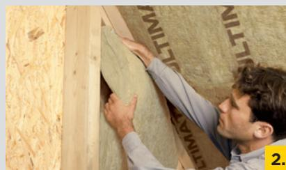
1. Bei einem Rastermaß von 625 mm kann die Dämmung einfach und zeitsparend direkt in das Gefach ausgerollt werden. Bei abweichenden Maßen ULTIMATE Holzbaufilz mit einer Klemmzugabe von 10 mm zuschneiden. 2. ULTIMATE Holzbaufilz ist so flexibel, dass die Dämmung ganz nach Bedarf in die Gefache geklemmt werden kann.
