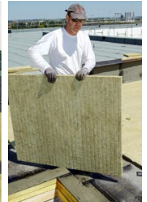
Verlegung der RP-TF auf ausgebessertem altem Dachaufbau
