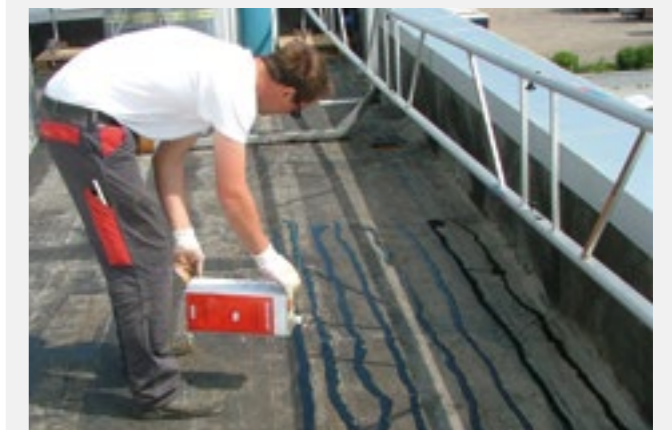
Rockpur wird streifenförmig auf die Dampfsperre aufgetragen.
