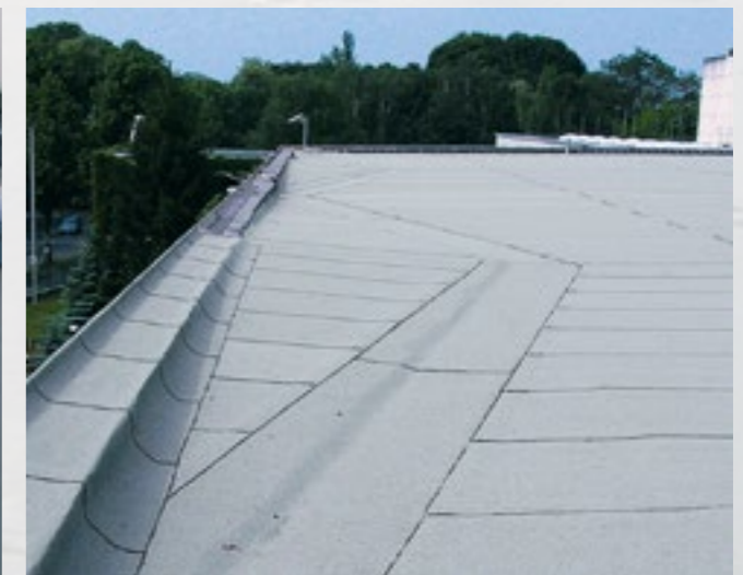
Punktentwässerung entlang der Attika
