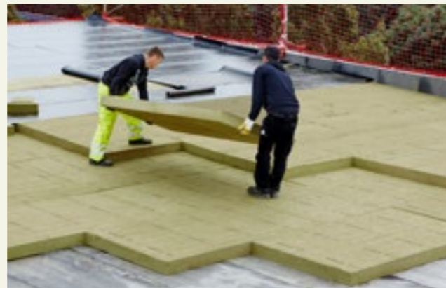
Die Verlegung der Dämmplatten erfolgt im Verband.
