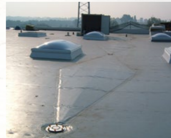
Punktentwässerung entlang der Kehllinien
