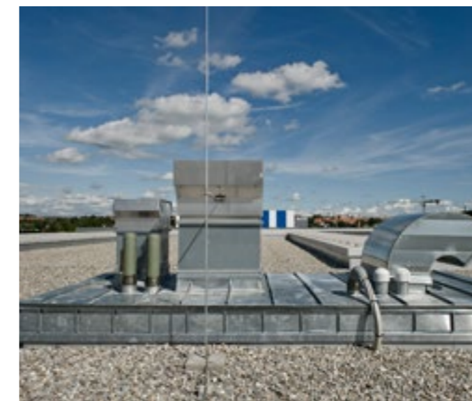
Dachaufbau lose verlegt mit Auflast
