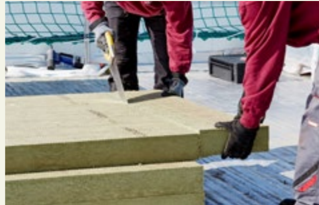
Die Dämmplatten lassen sich leicht zuschneiden.
