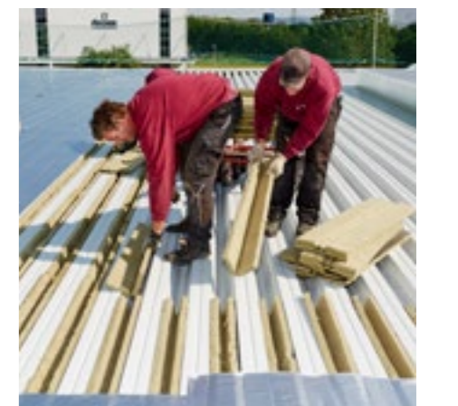
Einlegen von Akustik-Profilfüllern in Trapezprofile
