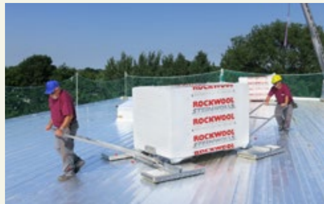
Einfacher Transport von Großgebinden mit dem Lift and Roller
