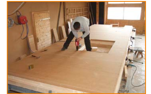
Ein Großteil der Wandelemente kann unabhängig von Witterungseinflüssen vorgefertigt werden
