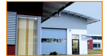
Hallen-/Bürofläche: 300/200 m 2 Bauzeit: 18 Tage
