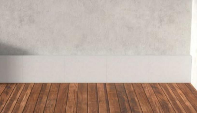
Erste Reihe waagrecht ausrichten. Stoß- und Lagerfuge werden nicht verklebt.
