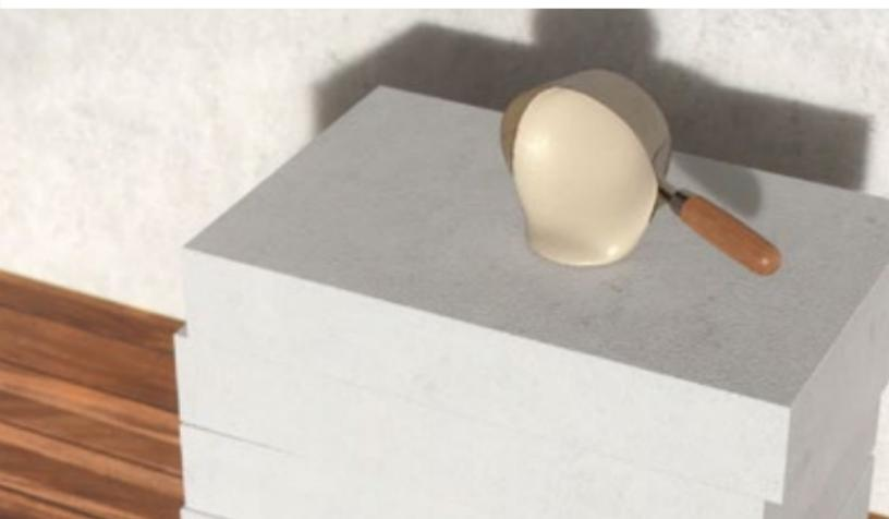
Leichtmörtel auf die Rückseite der Dämmplatte auftragen
